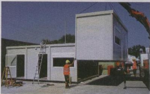
Giampiero Serena, amministratore della Serena Prefabbricati Srl di Albaredo di Veduggio (TV). In basso, fase assemblaggio monoblocchi
