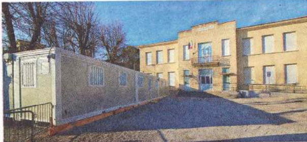
L'asilo di Villa di Villa chiuso per motivi di sicurezza, e i container che ospitano i bambini
